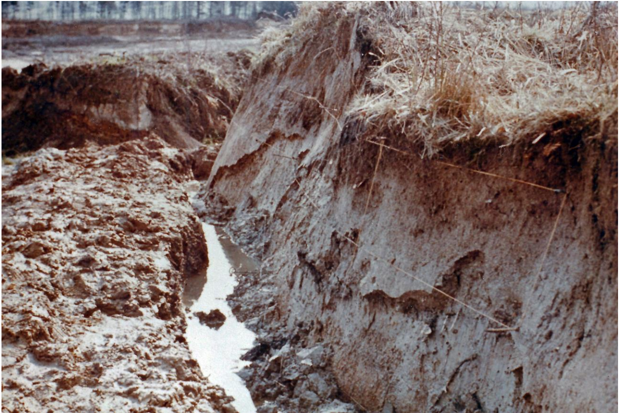
Das witterungsbedingt eingestürzte Profil
